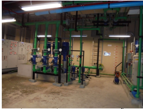
ภาพที่ 3-10 ห้องเครื่องประปา และถังสำรองน้ำใต้ดิน
