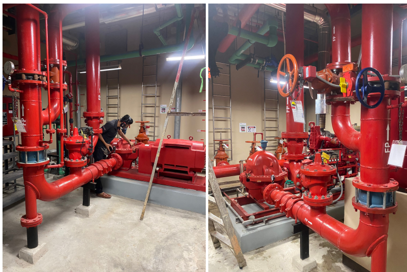
ภาพที่ 3-42 ตรวจสอบระบบ Fire Pump เป็นประจำทุกเดือน
