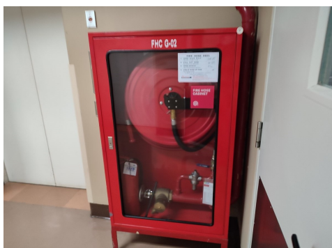
ภาพที่ 3-24 ตู้เก็บสายฉีดน้ำดับเพลิงและอุปกรณ์
