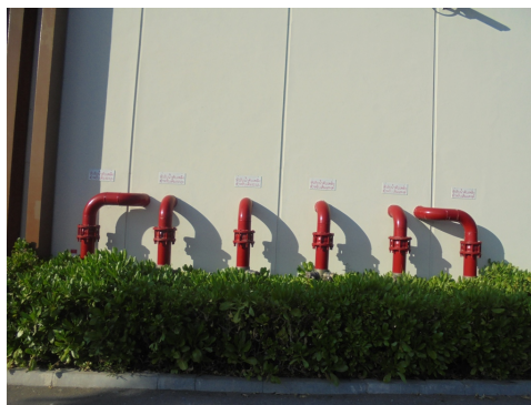
ภาพที่ 3-23 หัวรับน้ำดับเพลิงจากภายนอกของโครงการ
