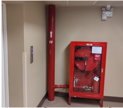
ภาพที่ 3-21 ท่อยืนสูบน้ำดับเพลิง และตู้เก็บสายฉีดน้ำดับเพลิง
