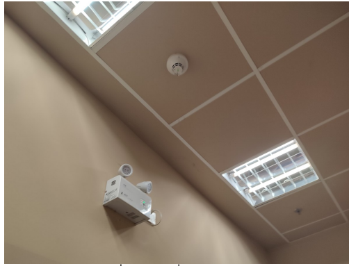
ภาพที่ 3-25 เครื่องตรวจจับควัน
