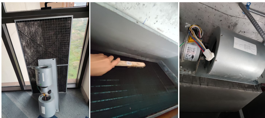
ภาพที่ 3-45 ล้างทำความสะอาดระบบปรับอากาศของอาคาร
