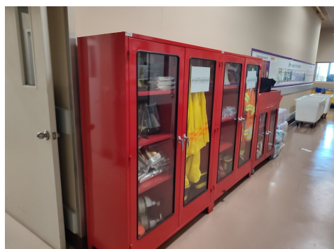
ภาพที่ 3-24 ตู้เก็บสายฉีดน้ำดับเพลิงและอุปกรณ์
