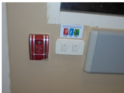
ภาพที่ 3-36 สวิตช์ไฟแยกเปิดปิดเฉพาะดวง และป้ายประหยัดพลังงาน
