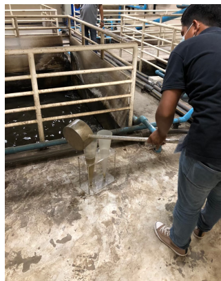
ภาพที่ 3-8 สูบน้ำกากไขมันออกจากบ่อดักไขมัน และดูแลรักษาระบบบำบัดน้ำเสีย
